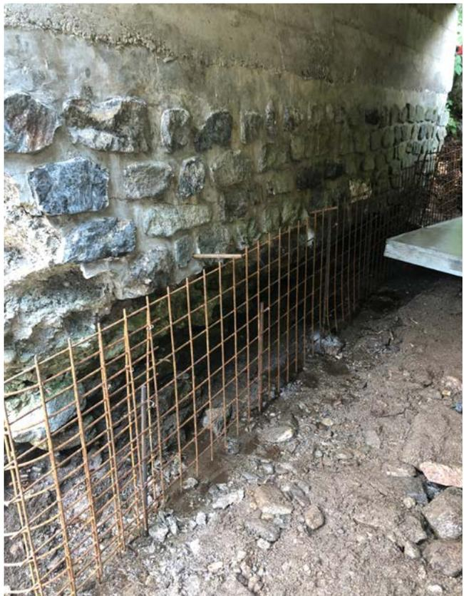
Zwei Brücken im Gemeindegebiet wurden vom Bachwasser im Laufe der Zeit so unterschwemmt, dass eine umfassende Sanierung des Unterbaues der Brücken unumgänglich war. Die Arbeiten der Sanierung wurde von der Baufirma Hartleb sehr rasch und zur vollsten Zufriedenheit durchgeführt.
