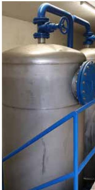
leistet ein keimfreies Wasser, ohne dabei die chemische Zusammensetzung des Wassers zu verändern. Im Zusammenhang mit diesem Umbau wurde auch die Entsäuerungsanlage einer Generalsanierung unterzogen und die Installationen in den Behältern teilweise erneuert.
