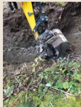
Die Sanierungsarbeiten am Trinkwassersystem werden in den kommenden Jahren Schritt für Schritt fortgeführt werden. Dieses Jahr haben wir begonnen, einen Teil der Quelfassungen am Tremmelberg zu sanieren. Dadurch hat sich die Schüttung um 5 m<sup>3</sup> auf ca. 37 m<sup>3</sup> erhöht. Aufgrund der nun seit bald 3 Jahren anhaltenden Trockenheit gehen jedoch
